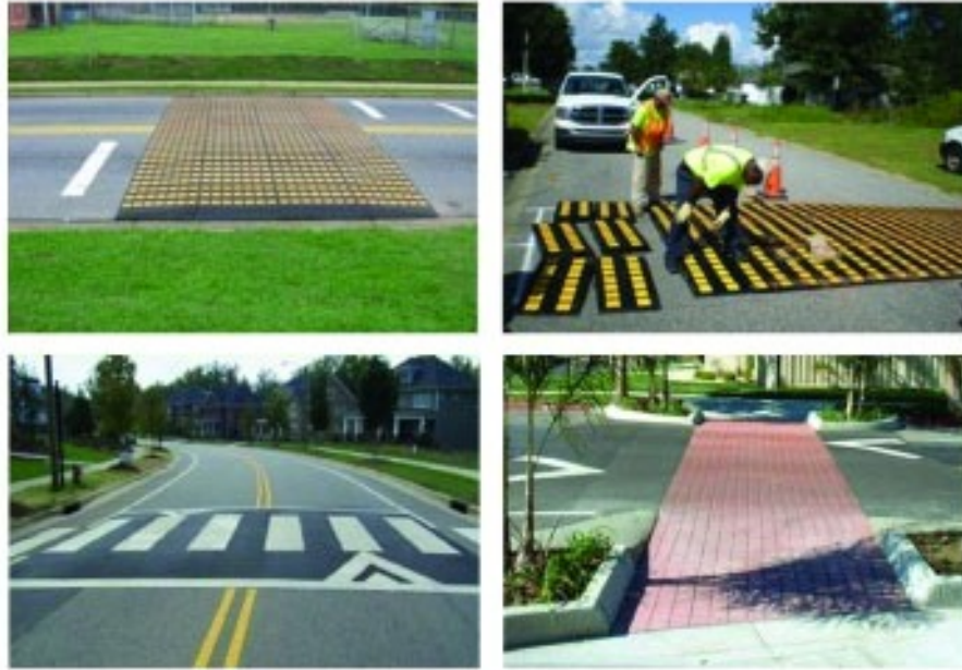
شکل (۱۵) سرعت گیرهای عرض و خطوط عابرپیاده برجسته به منظور آرام سازی جریان ترافیک
